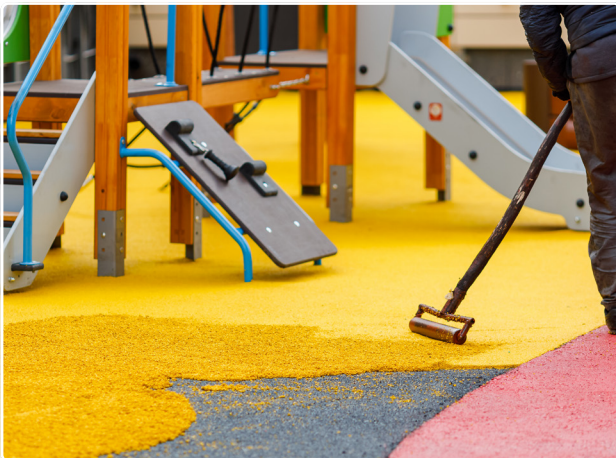
Sportudvar és játszótér építése újrahasznosított műanyaggal
