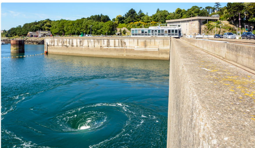
A Rance folyón üzemeltetett árapály erőmű turbinái örvényeket hoznak létre
