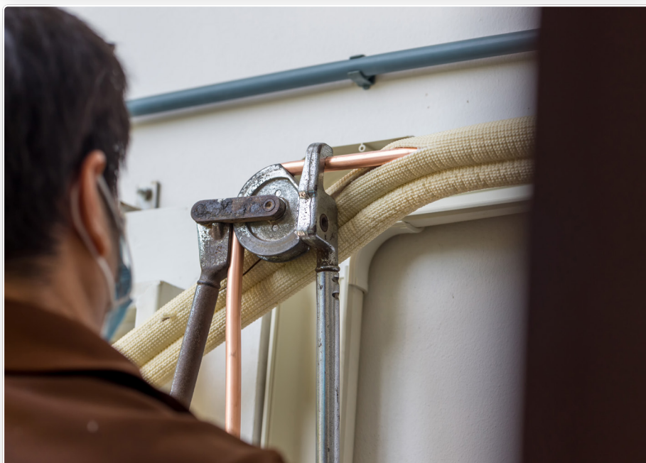
Rézcső hajlítás munkaterületen
